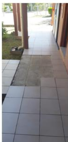
Sol de la coursive extérieure
