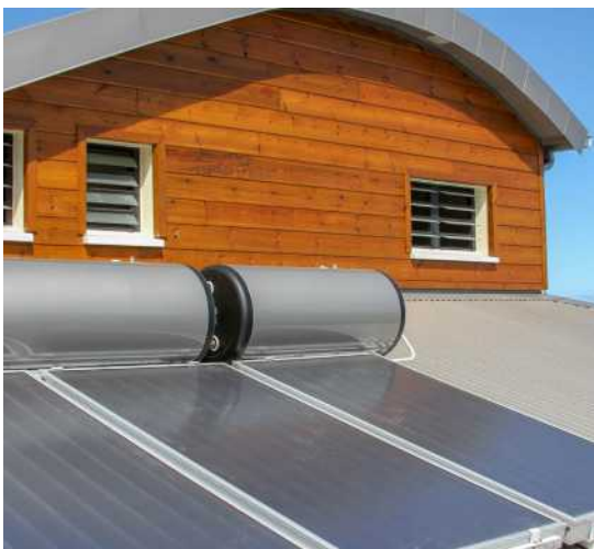
Installation pour le particulier en système couplé thermosiphon.
