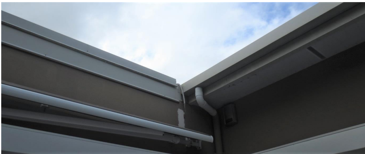
Vue du raccordement droit : l'avancée va masquer le départ du tuyau d'évacuation des eaux pluviales
