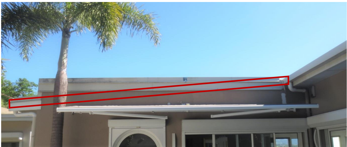
Vue du mur où réaliser l'avancée du toit (en rouge), la partie du mur au-dessus du trait rouge est à raser.
