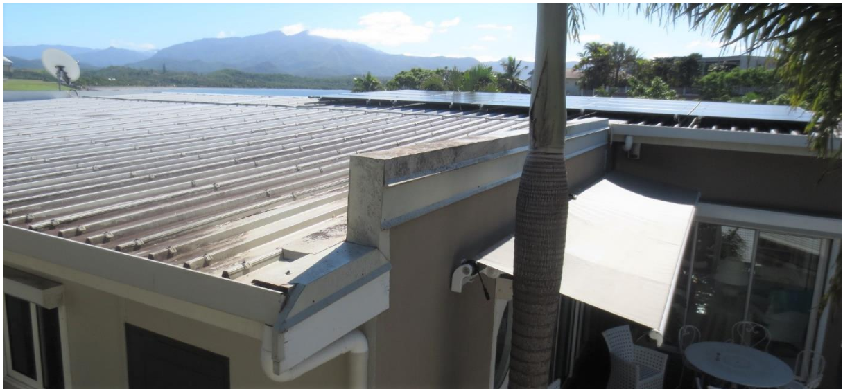
Vue du raccordement gauche. La gouttière est à remplacer par une plus longue et plus large. Nouvelle longueur de la gouttière : environ 9 m
